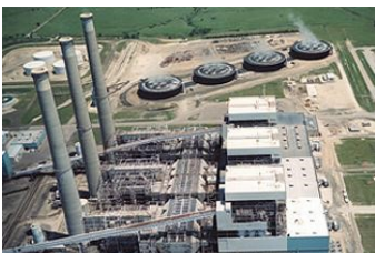
Jeffrey Energy Center in St. Mary’s, KS.
